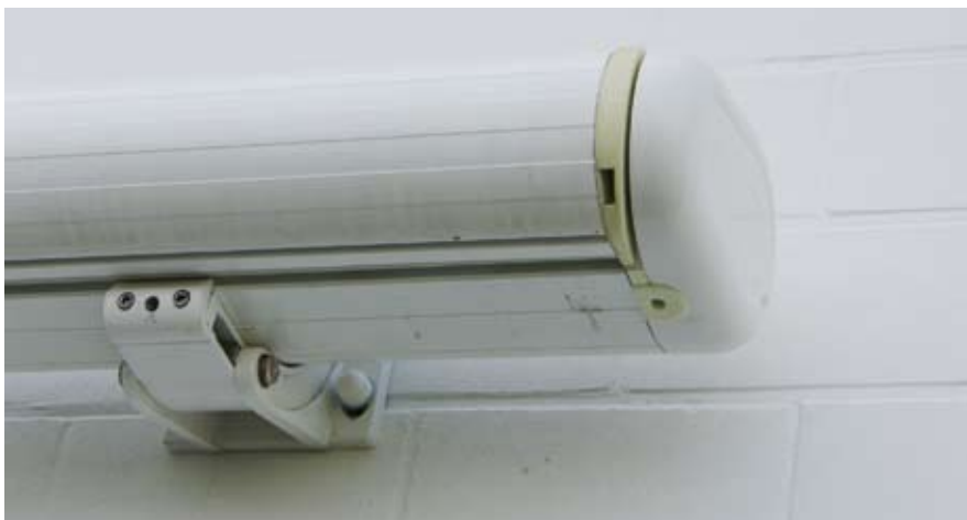
Deutliche Verfärbungen der Kunststoffteile nach nur 18 Monaten durch nicht UV-beständiges Material.
